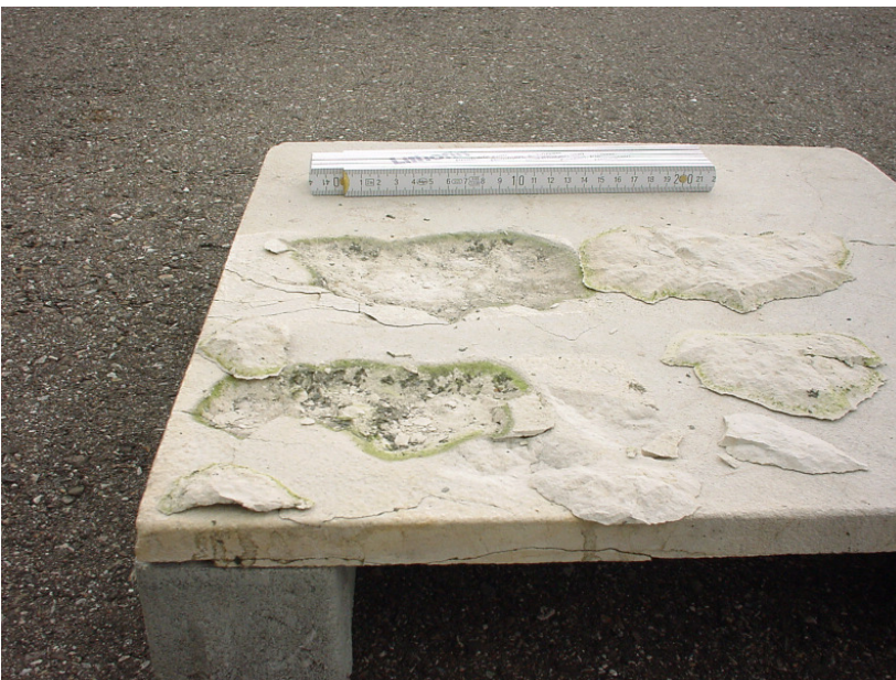
Freibewitterung von versiegeltem Kalkstein - Frostschaden
