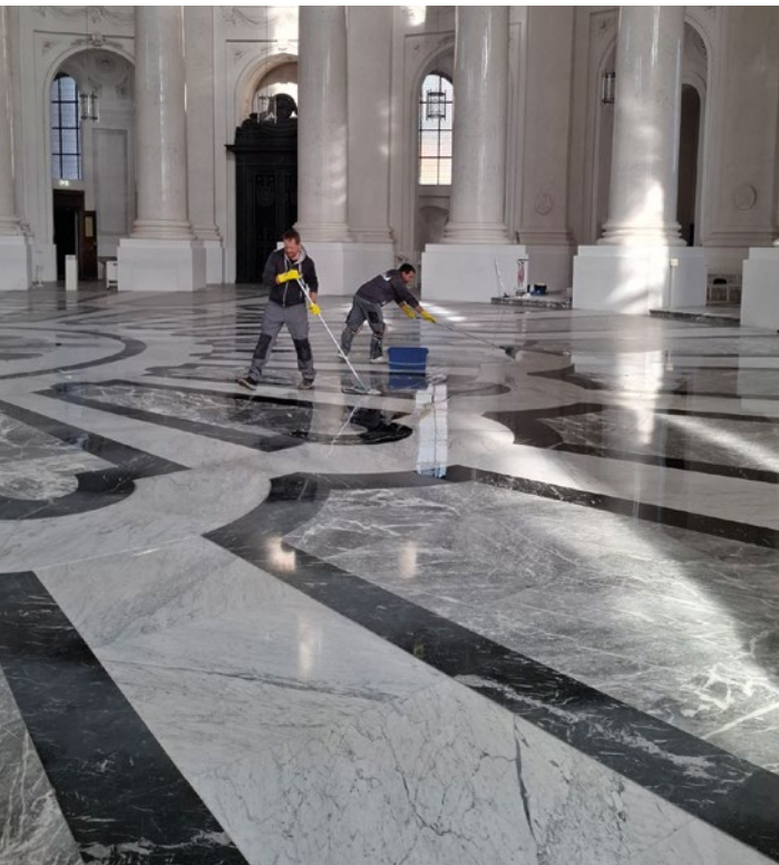
Anwendungstechniker von Lithofin unterstützten die Firma Vogt Fliesentechnik bei der Auswahl verschiedener Reinigungs- und Pflegeprodukte und -verfahren. Die Oberfläche wurde gereinigt und imprägniert. Zudem wurden Rostflecken entfernt. Fotos: Lithofin
