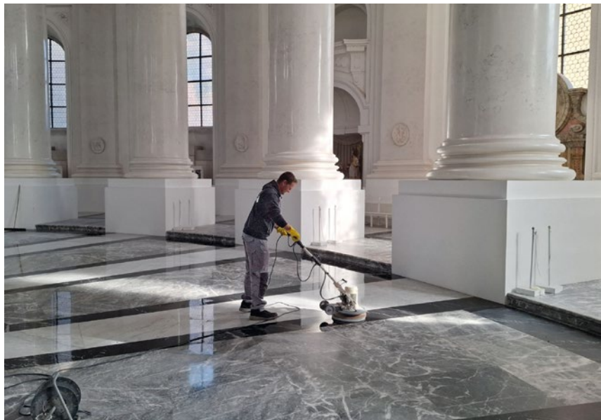
Anwendungstechniker von Lithofin unterstützten die Firma Vogt Fliesentechnik bei der Auswahl verschiedener Reinigungs- und Pflegeprodukte und -verfahren. Die Oberfläche wurde gereinigt und imprägniert. Zudem wurden Rostflecken entfernt. Fotos: Lithofin
