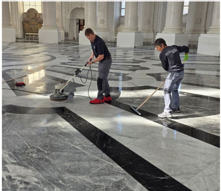
Anwendungstechniker von Lithofin unterstützten die Firma Vogt Fliesentechnik bei der Auswahl verschiedener Reinigungs- und Pflegeprodukte und -verfahren. Die Oberfläche wurde gereinigt und imprägniert. Zudem wurden Rostflecken entfernt. Fotos: Lithofin
